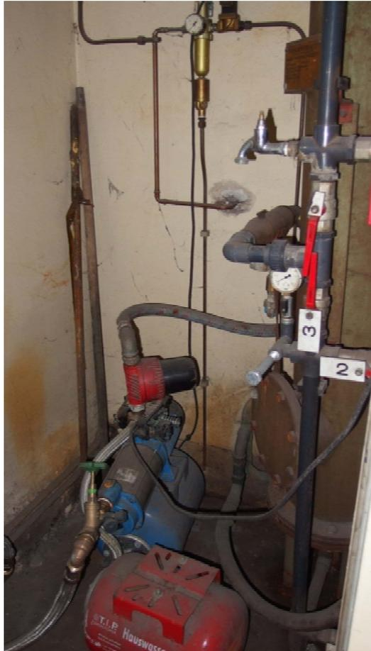
Abb. 5: Blick nach Süden auf die Wasseraufbereitungsanlage zur Trinkwassergewinnung im Sozialtrakt in der Werkstatthalle. Die Trinkwassergewinnung erfolgt über einen Brunnen auf dem Gelände.
